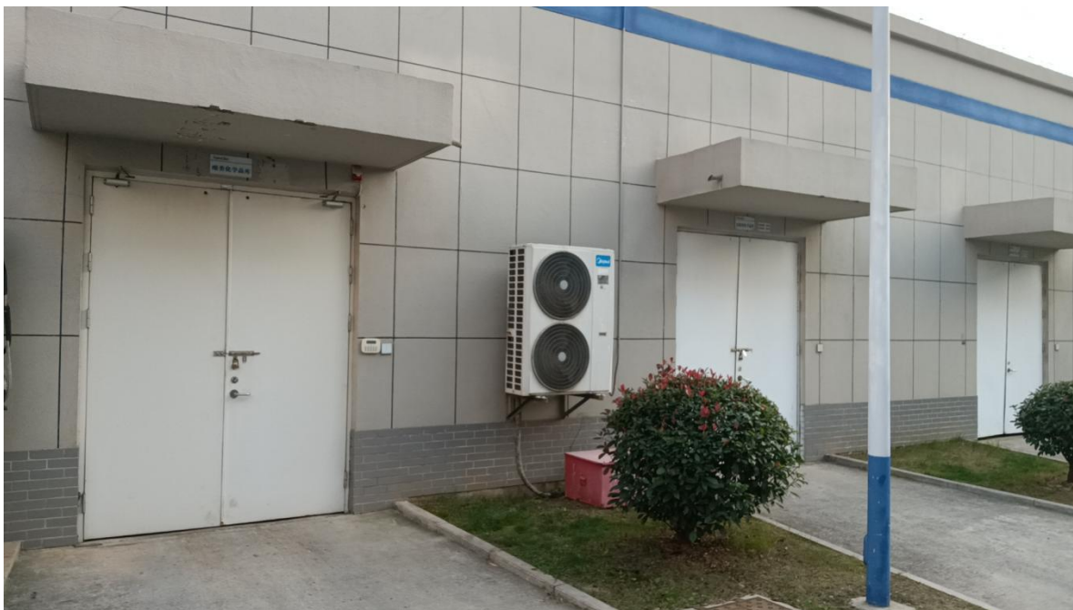
辅助用房南侧化学品仓库
