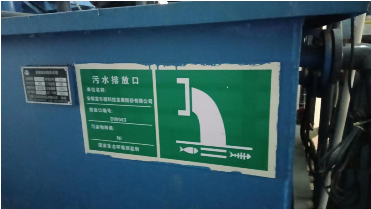
DW005 含镍废水排放口
