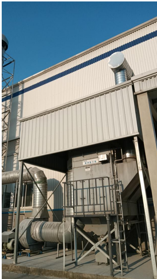
喷砂粉尘布袋除尘器
