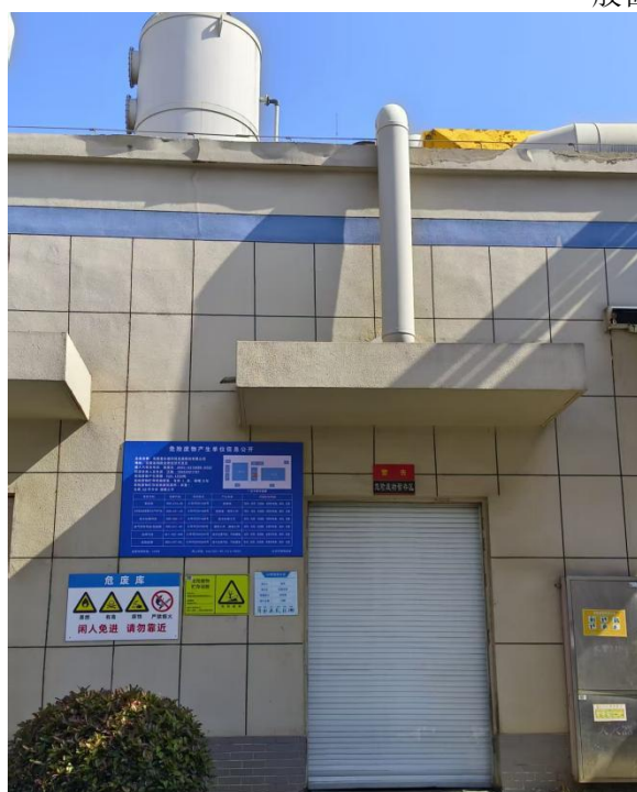
一期厂房外东侧的辅助用房内危废仓库 (危废库已设置应急管道引入DA007排气筒)
