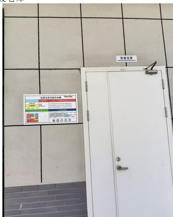
二期厂房外东侧危废仓库
