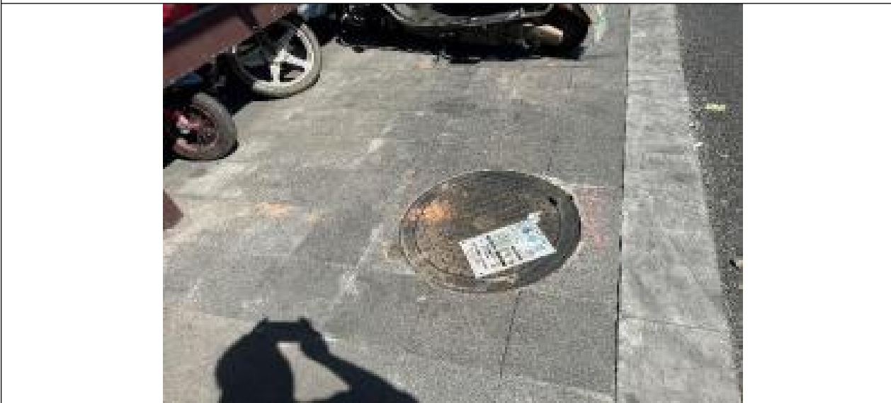
生活污水预处理池
